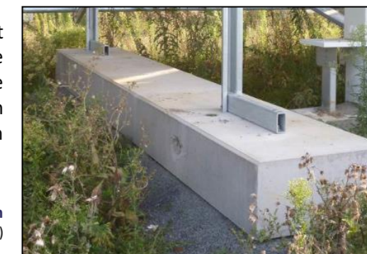
Figure 10 : Types de fondation - semelle béton
