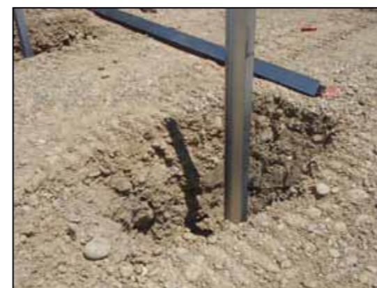
Figure 9 : Types de fondation - pieux battus
